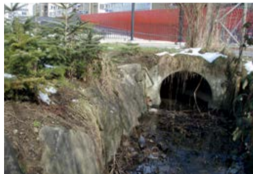
Der Bachabschnitt nach den SBB-Gleisen wird umgelegt und ökologisch aufgewertet.
